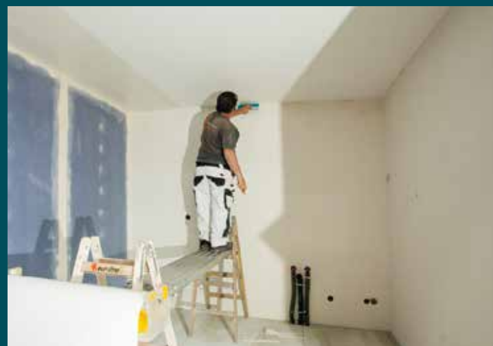
Der Innenausbau geschieht zu 90–95 Prozent unter kontrollierten Bedingungen in der Raumfabrik.
