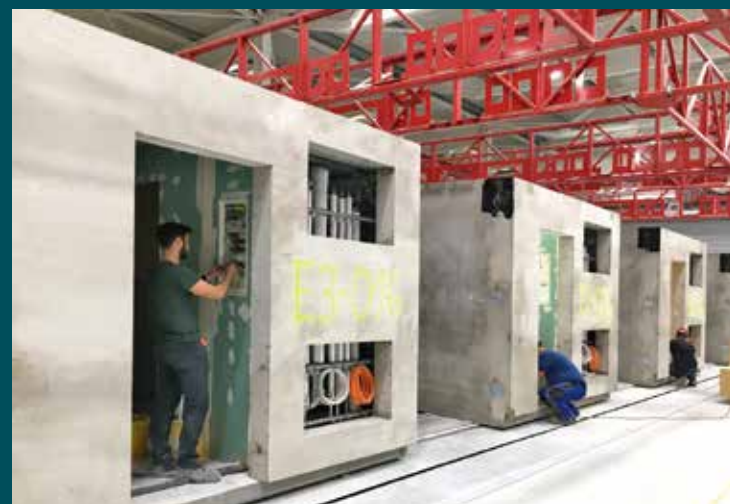
Das Rohmodul gleitet auf Schienen von Ausbaustation zu Ausbaustation.
