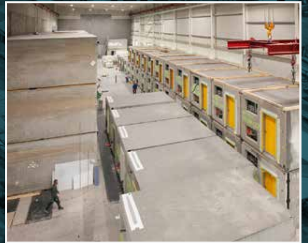
Ausschnitt Zwischenlager in HALLE 4
