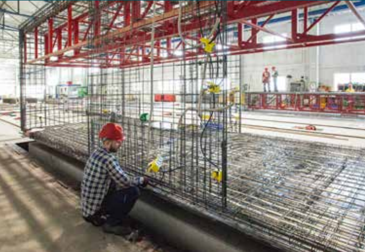
Im 3-dimensionalen Bewehrungskorb werden sämtliche Installationen integriert.
