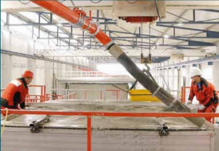
Der Spezialbeton wird in die senkrecht aufgerichtete Schalung gegossen.
